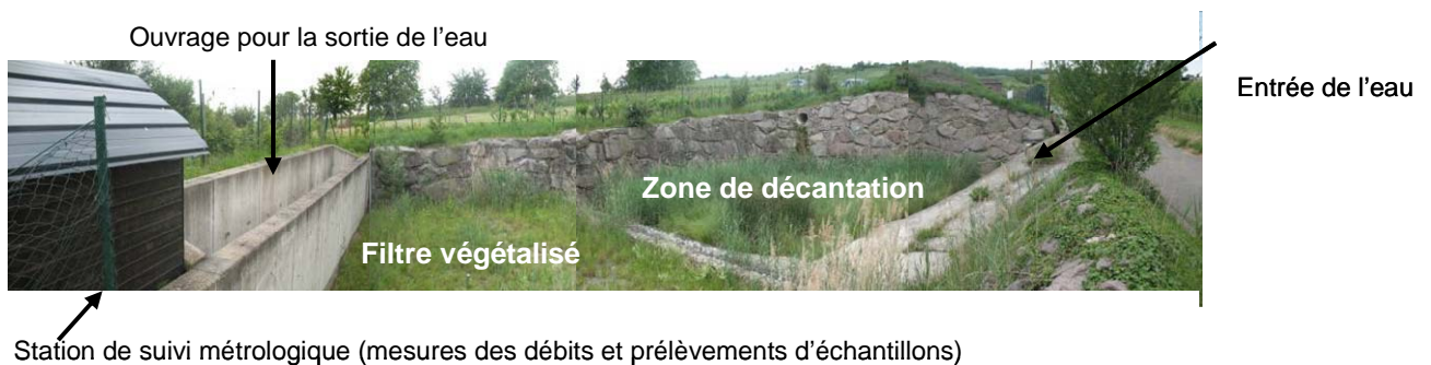
Schéma 7: Exemple de zone humide artificielle ArtWET : bassin d'orage à Rouffach, France (C. Grégoire)
