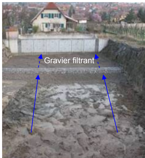
Figure 35 : Ajout d'un lit de gravier filtrant afin d'augmenter le temps de résidence des eaux dans le bassin (bassin de rétention et de remédiation du Waldweg, Rouffach, France)
