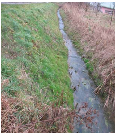
Fossé végétalisé, Eichstetten, Allemagne
